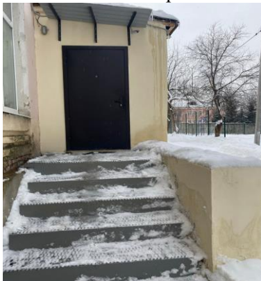
Рис.1. Текущий ремонт эвакуационного выхода.
